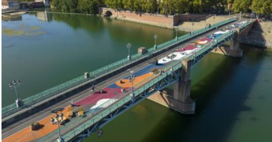
Fig 3. Le pont Saint Pierre, été 2022. Photo : Drone Toulouse Sud.
