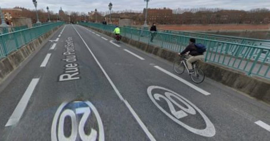
Fig 2. Le pont Saint Pierre en janvier 2023. L'aménagement est identique à celui présent avant l'été 2022. Capture d'écran Google Street View. Position : 43^{\circ}36'05.2''\text{N} 1^{\circ}26'03.2''\text{E}
