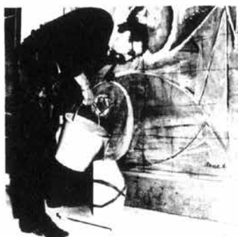
Remplissage du moule avec de la barbotine.
